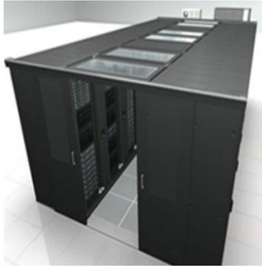
图2 冷通道地板送风实景图
