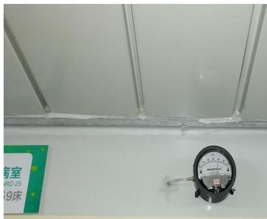
图 5 病房围护结构缝隙处理前后压差值变化
