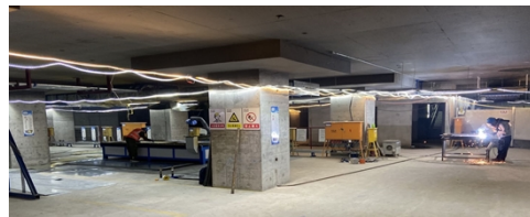
图 2 通风加工间实际场景照片
