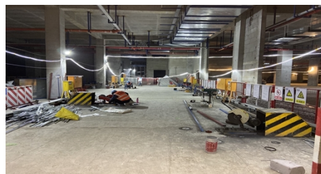
图 7 给排水加工间实际场景照片
