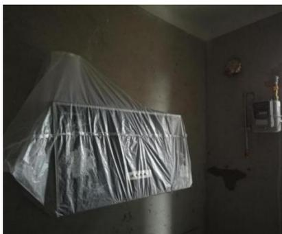
图 7 预装油烟净化设备的毛坯房厨房(墙壁上圆孔为直排口)
