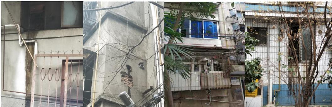
图 1 老旧小区住宅油烟排气道(直排)
