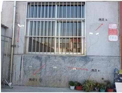
图 6 建筑外部测点布置
