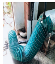
(b) 空气入口风管
