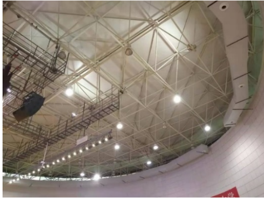
图 5 综艺大厅空调系统实景图
