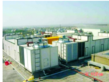
图 10 乌鲁木齐市某培训中心采用的机组照片
