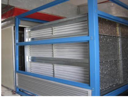
图 8 应用在西安某数据机房采用的管式 IEC 芯体
