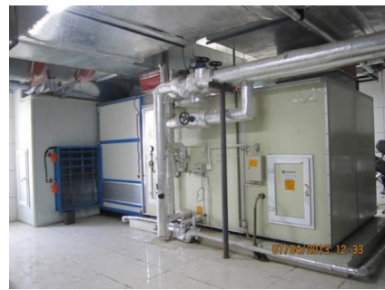
图 7 应用在西安某数据机房的蒸发冷却与机械制冷机组
