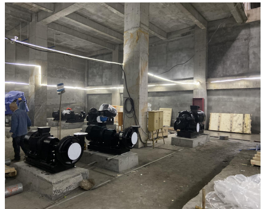
图 2 制冷机房实际场景照片
