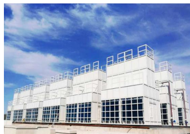
图 1 间接蒸发冷却冷水机组
