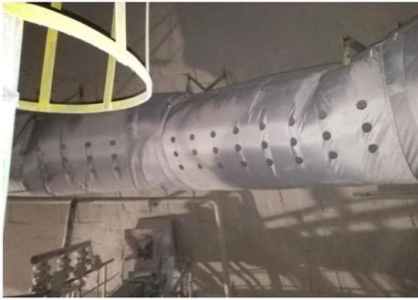
图3 回转窑工艺段送风口
