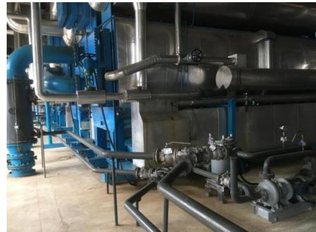
图 2 自配置胶球清洗装置吸收式热泵余热供热系统现场布置图
