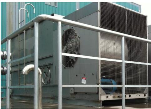
图 5 蒸发冷却塔外形图
