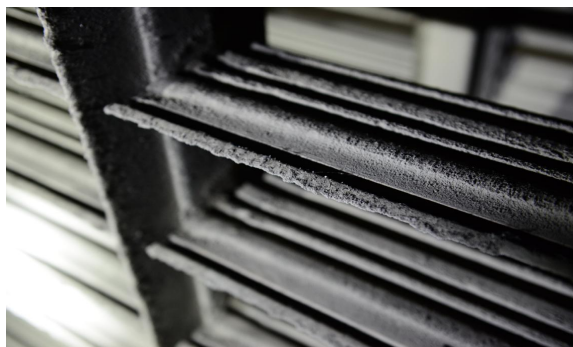
图9 典型地铁车站风阀现场照片
