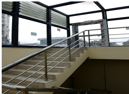
图15 磨子桥站消防专用通道兼做新风井地下实拍图
