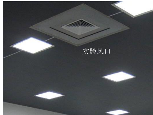
图 7 散流器实验安装图
