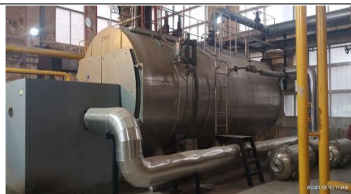
图 1 西安某高校学生浴室热水供应锅炉
