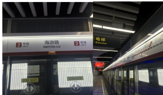
图 1 海游路上部开闭式站台门系统
