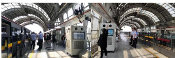
图 13 天津地铁 1 号线地铁站实际工程
