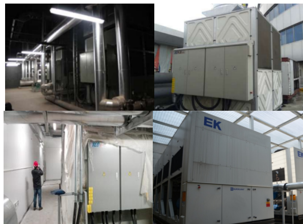
图 16 国内地铁站应用蒸发冷凝实际工程
