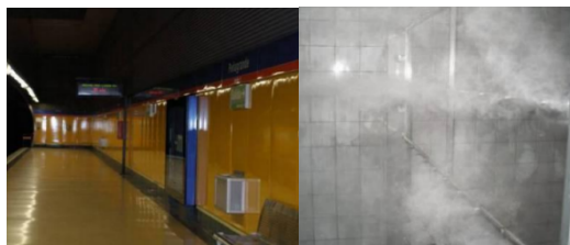
图10 马德里地铁站实际工程
