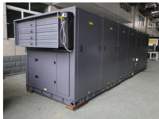
图2 20000m³/h 风量的复合式露点间接蒸发冷却空调机组工作原理图、实物图
