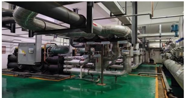
图1 地源热泵系统热泵机房
