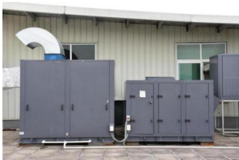
图 3 露点间接蒸发冷却空调机组实物图和结构示意图
