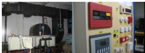
暖通空调实验台
