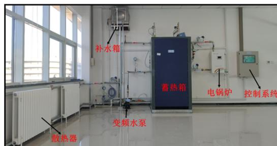
图 2 低谷电能水蓄热供暖系统实物图
