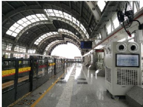
图 2 广告牌式蒸发冷却空调在天津地铁华山里高架站的应用
