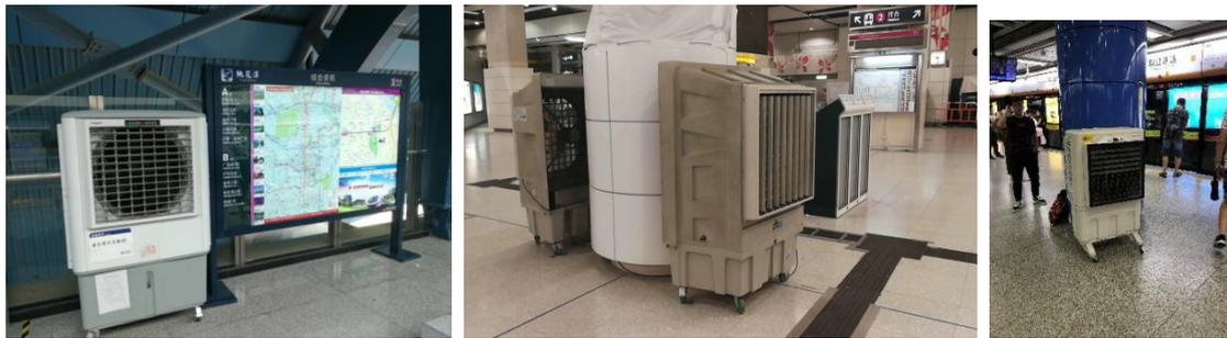
图 1 单元式蒸发冷却空调在地铁站的应用
