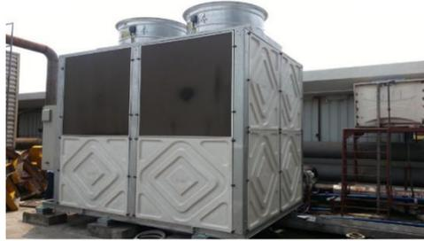
图 9 广州地铁 2 号线三元里站板管型蒸发冷凝冷水机组
