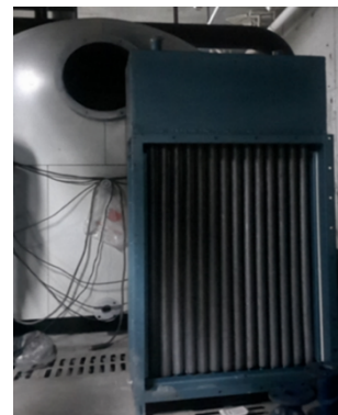
图 8 安装施工现场图
