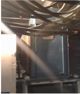
图 9 重力热管换热器设备安装图
