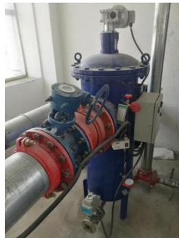
图1 本工程水系统采用的全自动刷式过滤器
