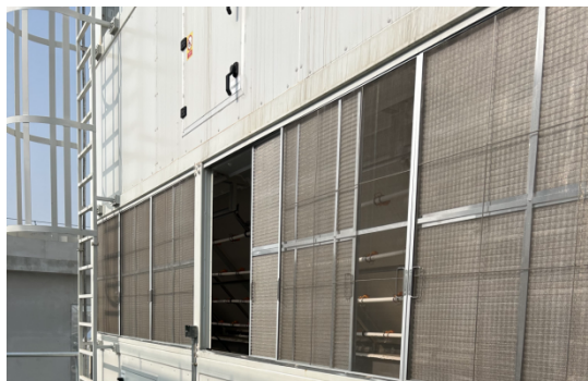
图 2 过滤网外层增设不锈钢纱网实物图
