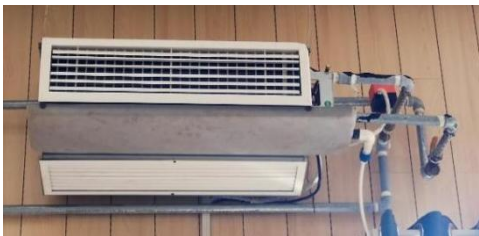
图 5 风机盘管实物图
