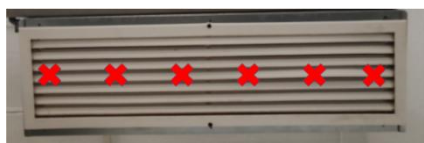
(b) 风机盘管回风口风速测点示意图
