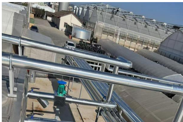
图 10 现场施工照片
