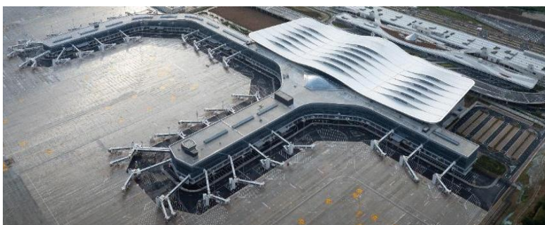
(b) 混凝土屋顶实景图
