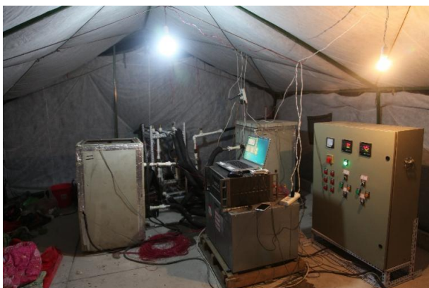
图 4 现场热响应实验系统
