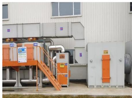
(b) 除水过滤器及催化燃烧炉
