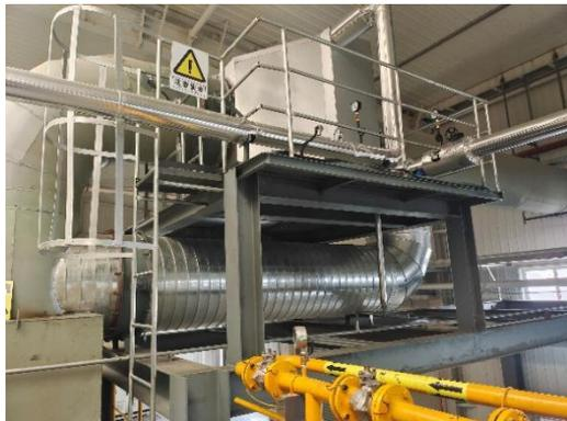
图 3 管式换热器
