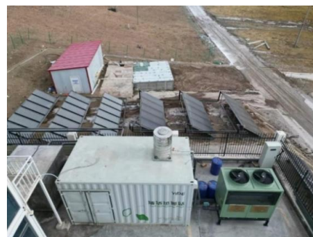
图 1 试验点现场实验平台
